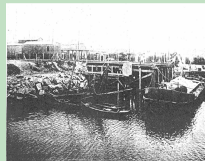
Imagen 4. Fotografía del “nuevo amarradero para lanchones a vela”, probablemente desconocida para muchos, con una vista parcial de la primitiva cabecera de la Dársena de Pescadores en construcción. Por delante de la proa del vagón basculador y lindero a terrenos de tierra y piedra, dos lanchones sin su velamen. Foto circa 1921. (Ghys, Y. M., 2012).
